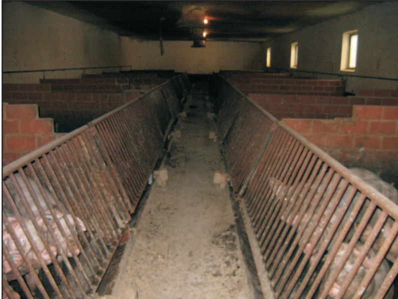
Längstrogstall mit geschweißten Schwenkgitter vor dem Umbau
