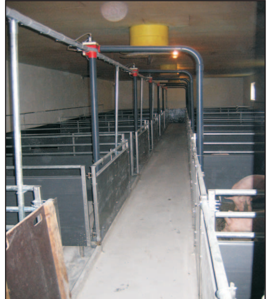
Längstrogstall nach Umbau
